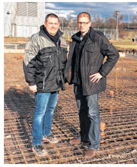
Investor Peter Bach (r.) und Bauunternehmer Alexander Wagner auf der Baustelle.
