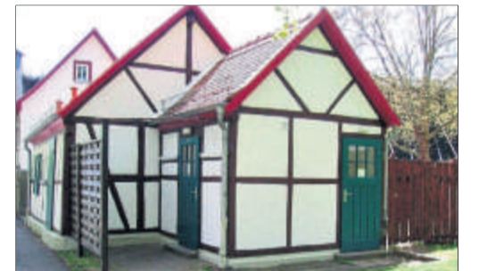
Am Montag beginnen die Arbeiten für die Instandhaltung des Toilettenhäuschens am Ludwigsbrunnen. (Foto: pv)
