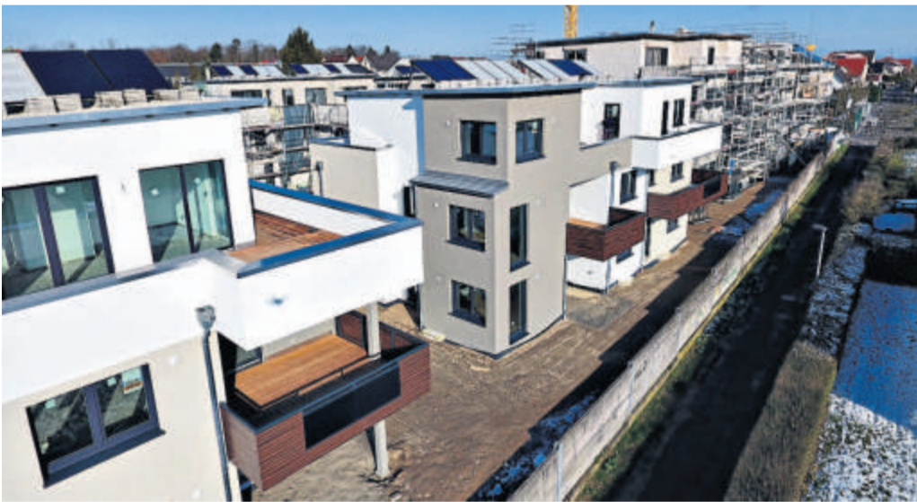
Die Bautätigkeit geht zügiger voran als geplant. Noch in diesem Jahr soll der Gesamtkomplex fertiggestellt sein. (Foto: pv)
