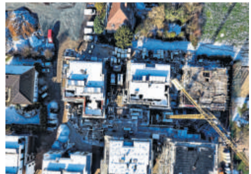
Im Mai sind die ersten Häuser bezugsfertig.
